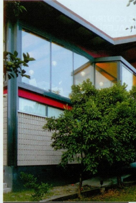
GS Sera Proje yeri: İstanbul / Beyoğlu Proje tarihi: 2006 – 2006 Toplam inşaat alanı: 200 m 2
