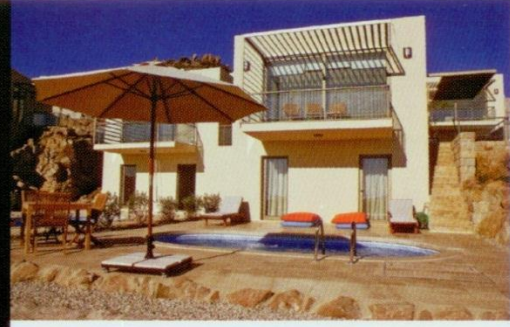
Aegean Hills Proje yeri: Bodrum Proje tarihi: 2005 – 2006 Toplam inşaat alanı: 8.840 m 2
